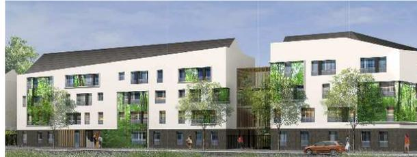
« Une toiture asymétrique valorisant le pan le plus long côté de préférence au sud, optimise la surface de panneau solaire exploitable et donc la production sur l'opération conformément à l'objectif du dossier de réalisation de la ZAC. Les toitures asymétriques sont donc autorisées dès lors qu'elles permettent d'améliorer le potentiel d'énergie renouvelable du quartier ».
