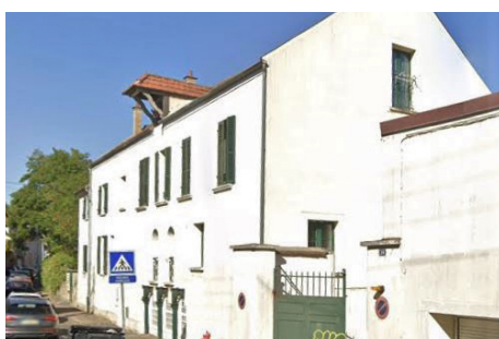
Façade Ouest de l'ancien moulin de Poignet en 2021, rue des trois moulins
