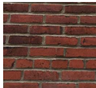
Reprise des joints au ciment
