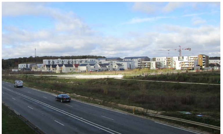
Vue sur l'écoquartier Woodi en cours d'aménagement
