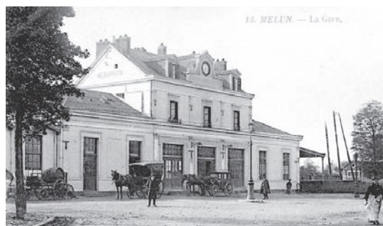
Gare de Melun au début du XX ème siècle, Source : Plateforme Ouverte du Patrimoine
