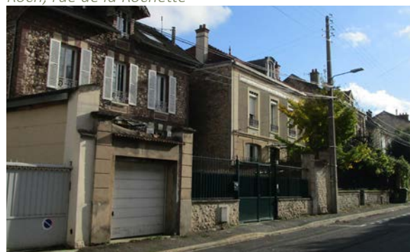
Annexe sur voie, rue de Dammarie
