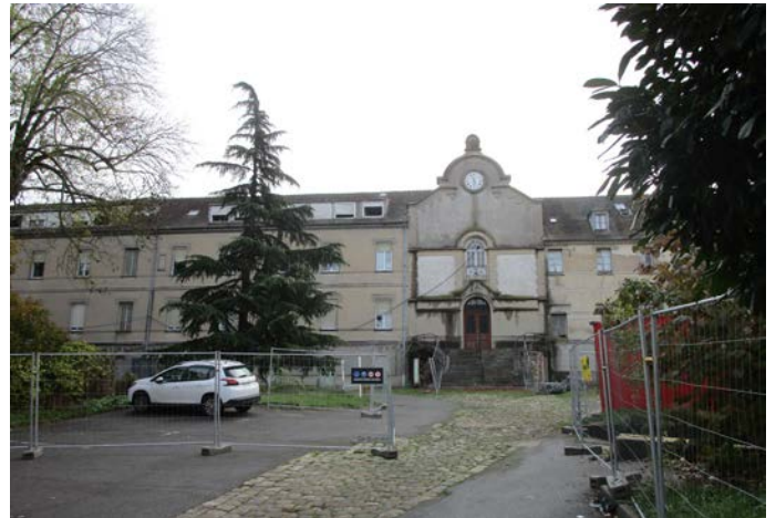
Réhabilitation d'un ancien bâtiment du centre hospitalier Marc Jacquet en logements
