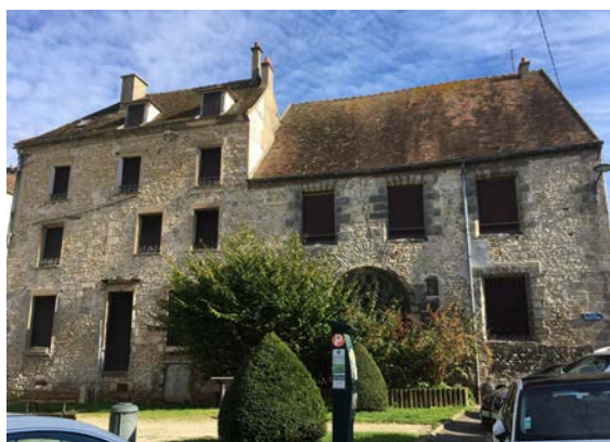
Le Prieuré Saint-Sauveur bâti en pierre calcaire et en grès, couverture en tuiles plates
