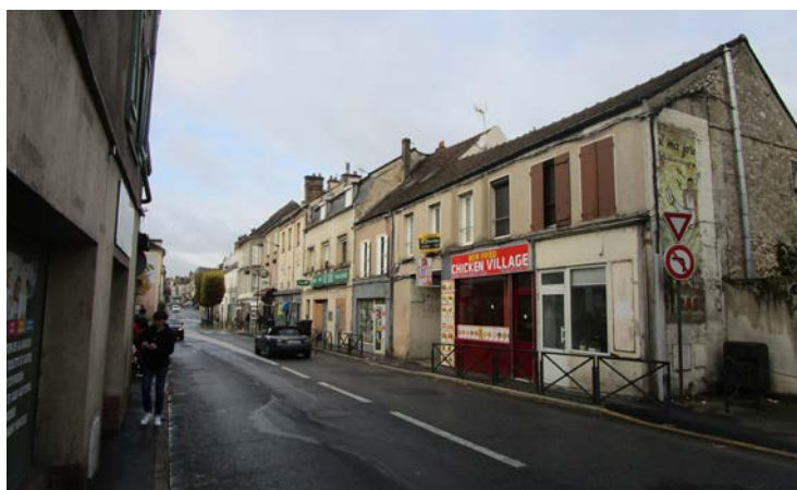
Trottoirs étroits, Rue Saint-Liesne
