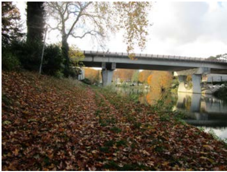
Bords de Seine à proximité de la RD 606
