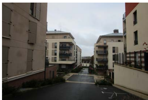
Logements collectifs, rue du capitaine Bastien
