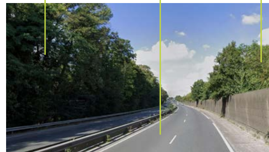
La RD 606, rupture entre l'espace habité de Melun et le parc Debreuil
