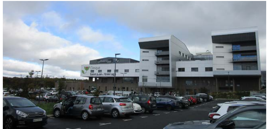
Le Santépôle situé sur la frange Nord de Melun
