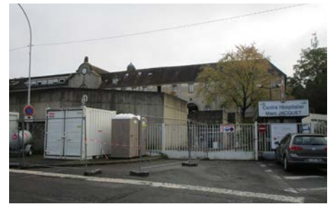
Le couvent des Récollets en cours de changement de destination (logements)
