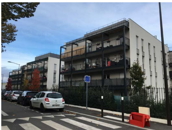
Logements collectifs, rue Marcel Houdet
