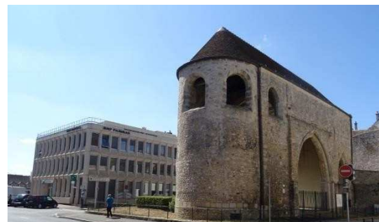
Ancien prieuré St Sauveur (MH)
