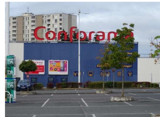
Enseigne en toiture
