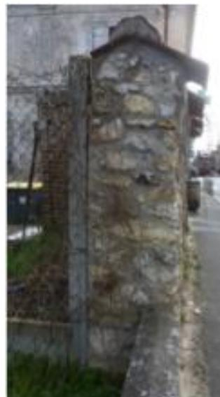
profil d'un mur de clôture traditionnel : en maçonnerie protégée par un chaperon en tuile plate et demi ronde.
