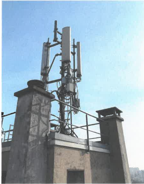
Vue de la terrasse S2 avant travaux
