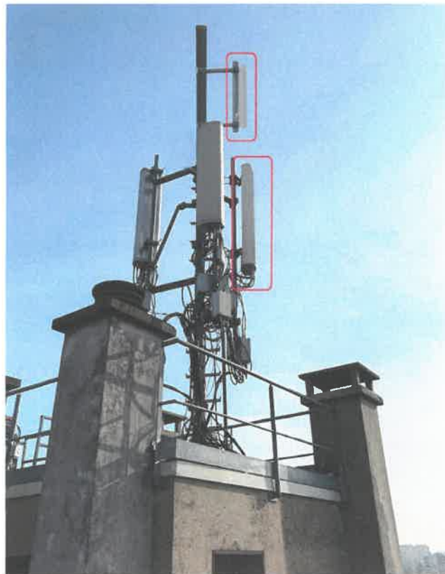
Vue de la terrasse S2 après travaux
