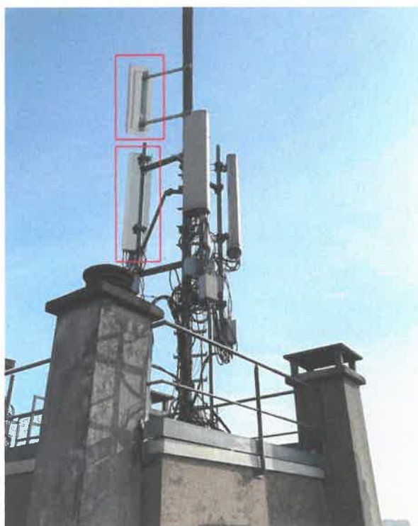
Vue de la terrasse S0 après travaux
