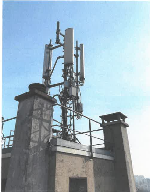
Vue de la terrasse S1 avant travaux
