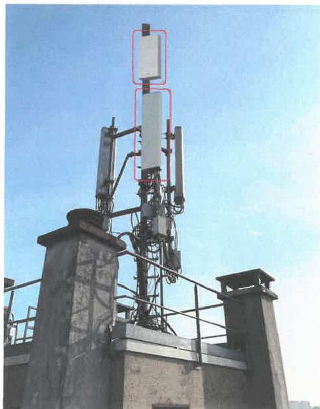
Vue de la terrasse S1 après travaux
