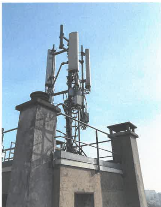
Vue de la terrasse S0 avant travaux
