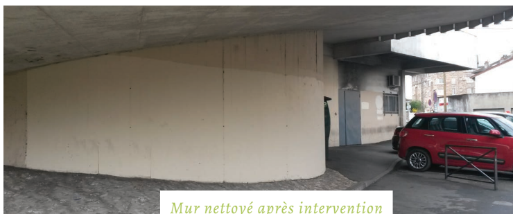
Mur nettoyé après intervention
